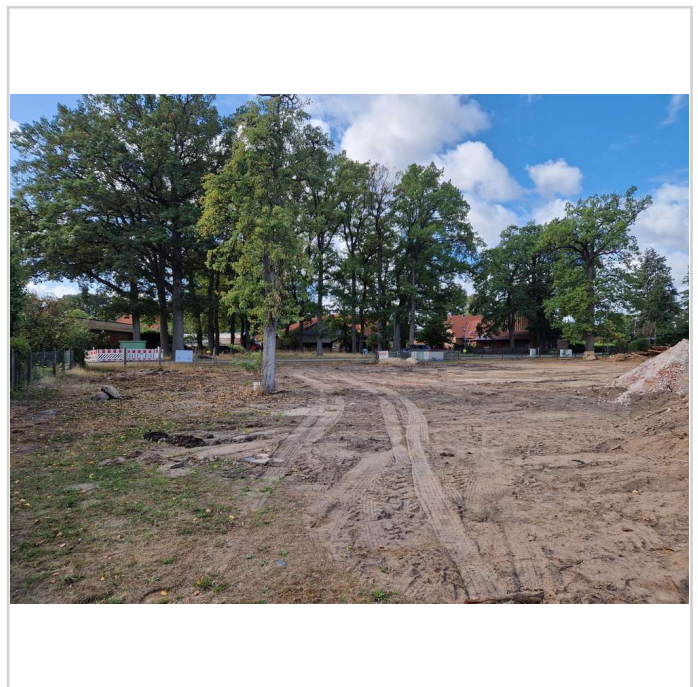
Ansicht nach Süden zur Straße
